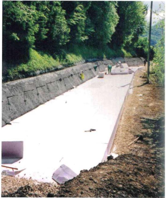
Photo 5 : réparation d'un glissement de terrain sur pente
