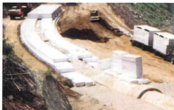
Photo 7 : remblai allégé sur une conduite forcée
