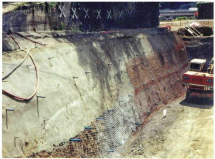
Photo 4 : exemple de confortement amont par paroi clouée.
