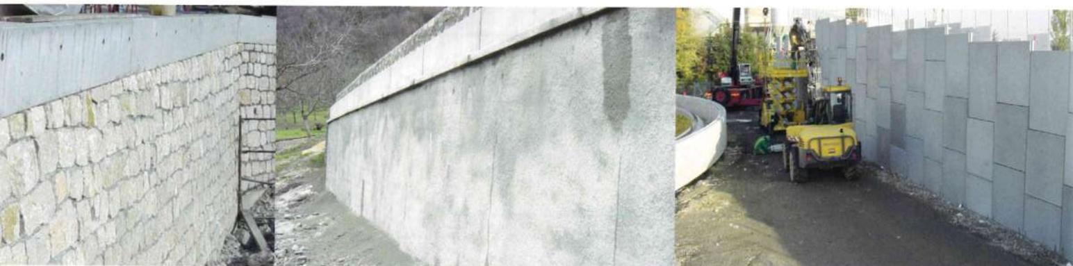
Photo 12 : parement en béton projeté
