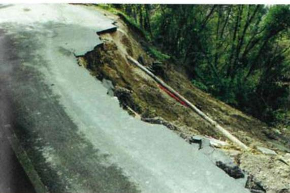
Photo 3 : exemple de glissement de terrain sur pente
