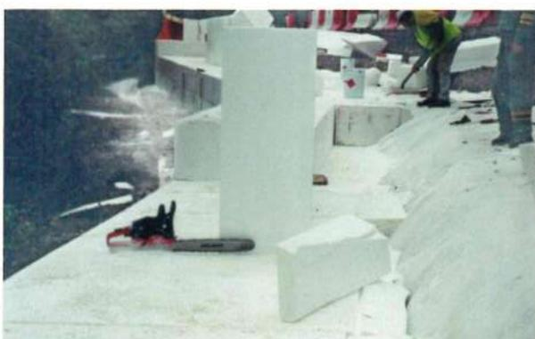
Photo 16 : remplissage arrière par chutes de polystyrène
