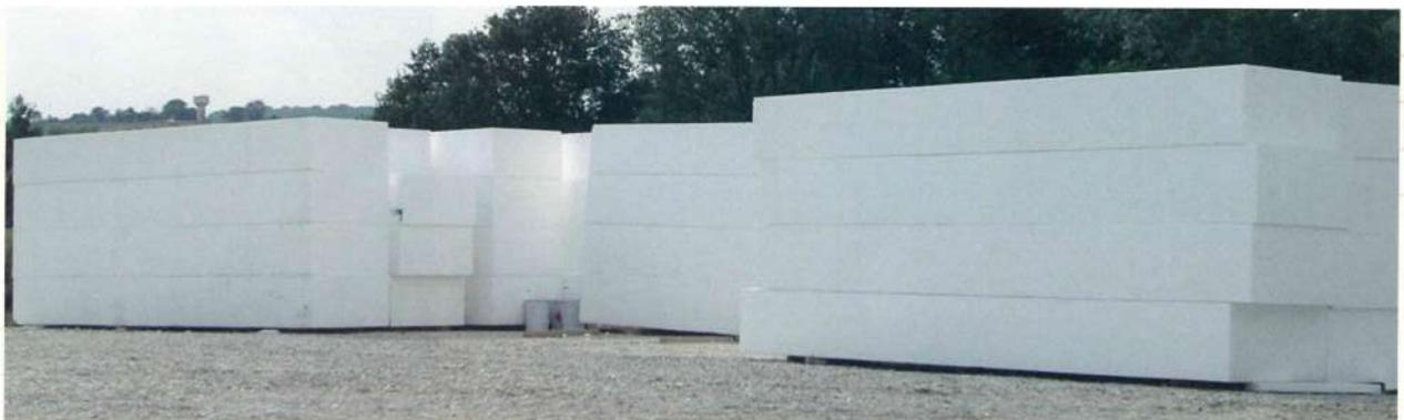
Photo 8 : stock de polystyrène expansé sur chantier
