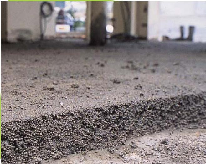
*PolyBéton se travaille comme un béton classique, avec les mêmes outils. Il est seulement plus léger et plus confortable à poser.*
