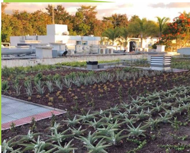
*Les plaques s'emboîtent facilement et se posent directement sur le toit. On peut ensuite y mettre un géotextile et du terreau pour les plantations.*
